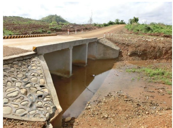
設置された橋
