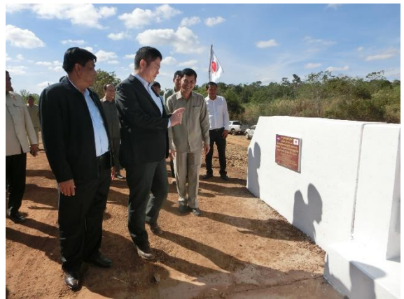
新しく建設された橋を視察する来賓と関係者
