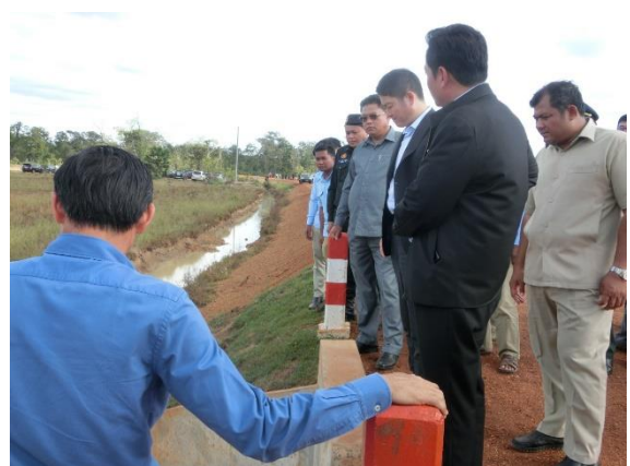
カルバートを視察する来賓と関係者
