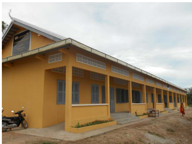
③ 完成した校舎
