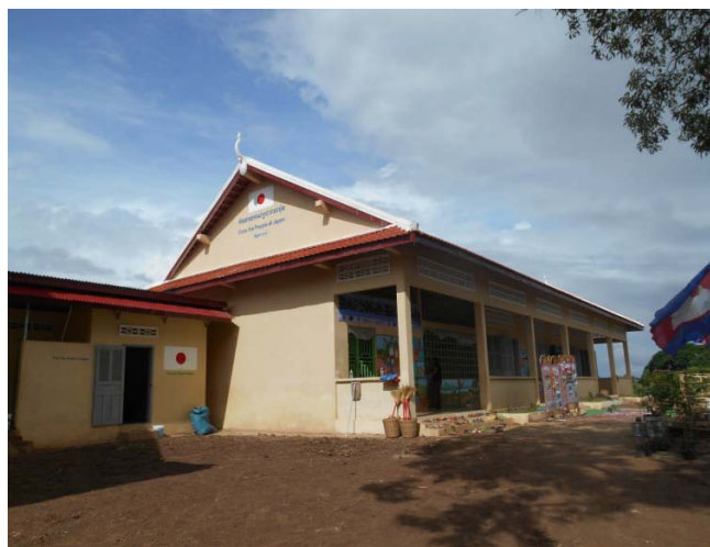
⑤新園舎の全景
