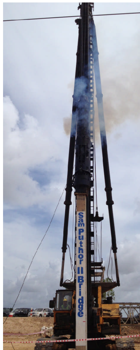
起動する杭打ち機
