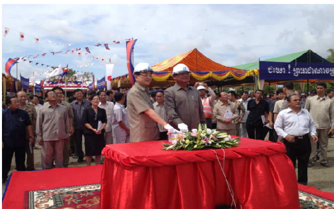
杭打ち機のスイッチを押し大使（左）と副首相（右）
