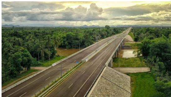
完成した国道5号線の様子
