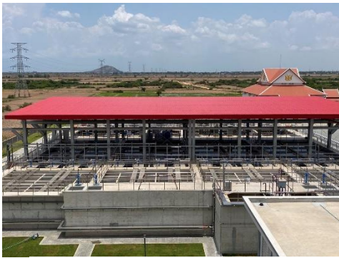
整備されたシェムリアップ上水道
