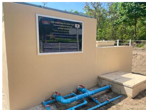
完成した浄水施設
