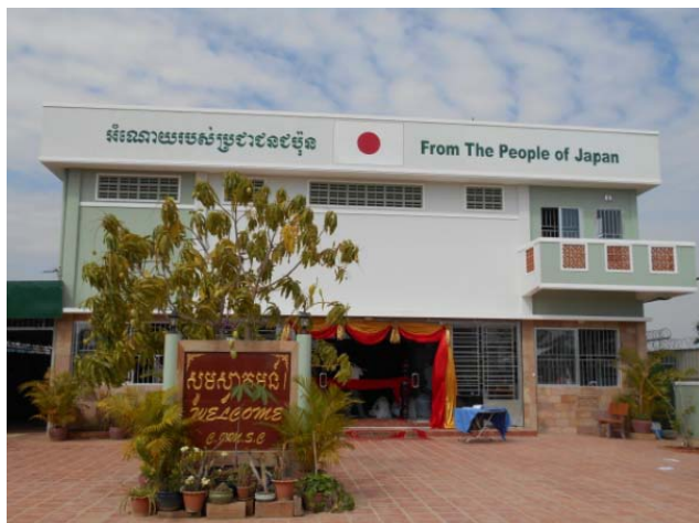
③ 完成した建物の概観
