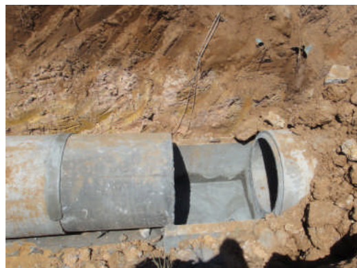
工事中の洪水排水管路
