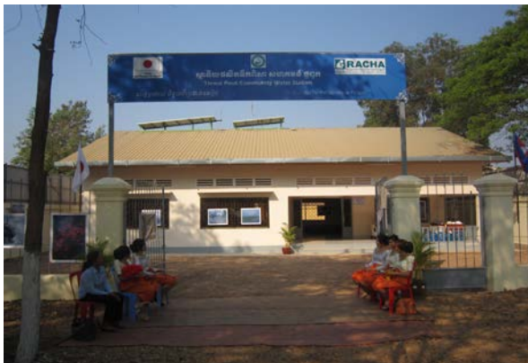
⑤完成した建物の外観
