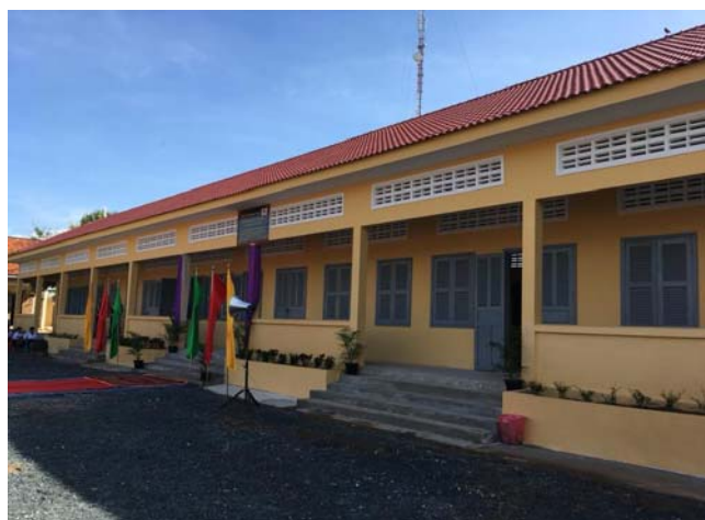
完成した新校舎
