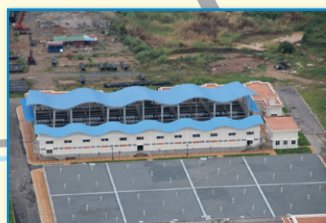
ニロート浄水場
