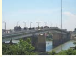
チュルイ・チョンパー橋修復計画 (日本橋) (GA: 29.89億円, '92)
