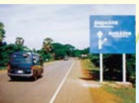
国道6号線シムリアップ区間改修計画 (GA: 13.07億円, '00)
